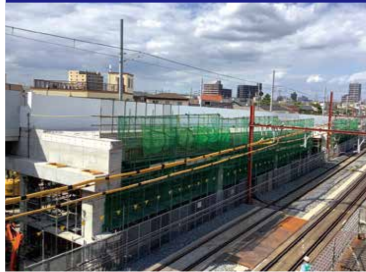
谷塚方高架橋
