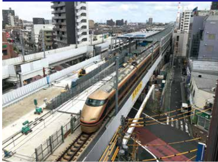
第37号踏切道付近
