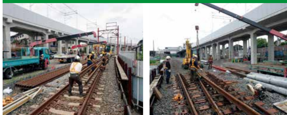
愛宕駅付近 仮線撤去工事状況
