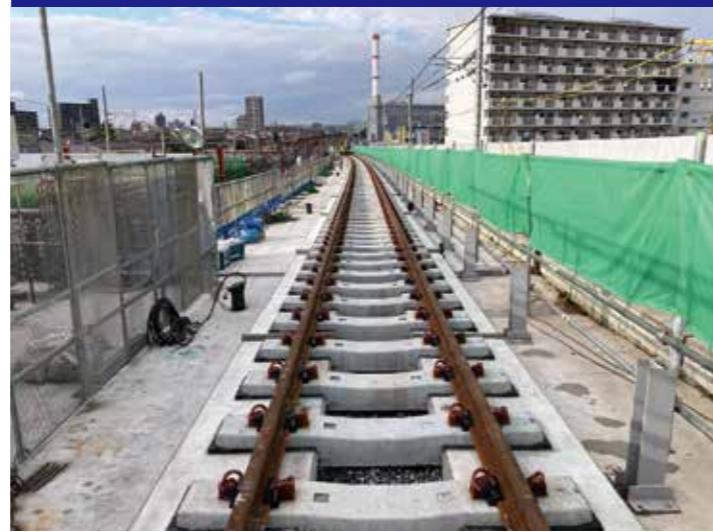
谷塚方取付部軌道
