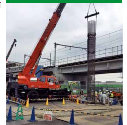
野田市駅付近 高架橋基礎工事状況
